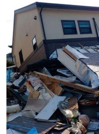
震度7を観測した、益城町震度計半径200m周辺の50%の木造建物が全壊、2000年以降に建築された耐震等級2の木造建物を含む最大7棟が全壊。
